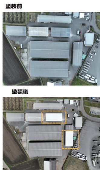
図4 遮熱塗料施工前後
