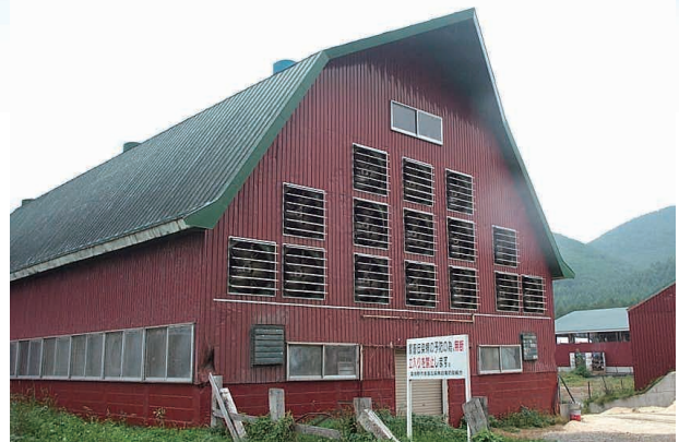
毎秒4mの風が吹くギャンブル型TS牛舎のトンネル換気（北海道富良野市）ストール（牛）と直角に風が当たる。小出氏提供
