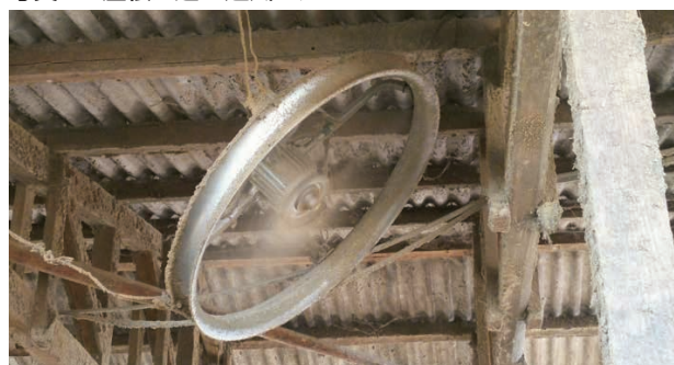
写真2 屋根に近い送風ファン?
