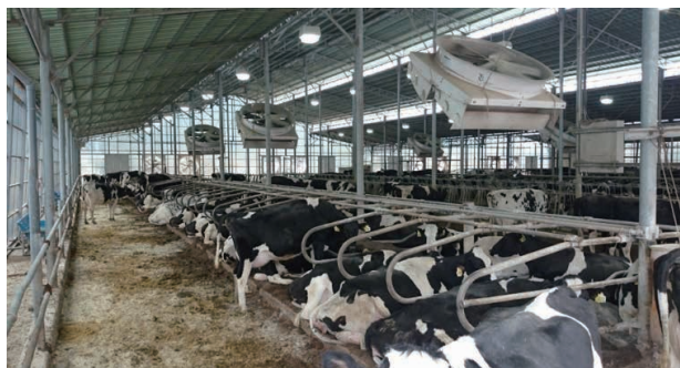
写真6 フリーストール牛舎での大型ファンの設置
