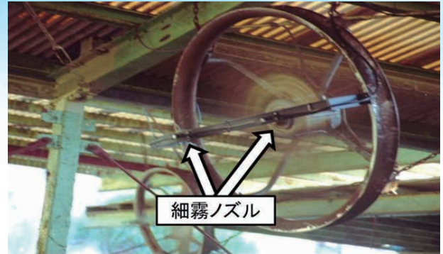
写真8 送風ファンの前に細霧ノズルを設置する
