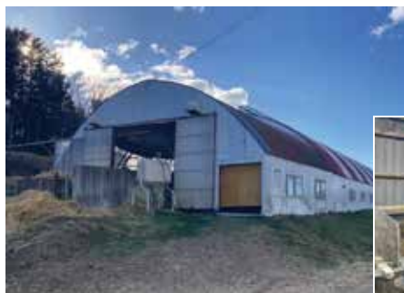
◀ハッチの哺乳舎（外観）
