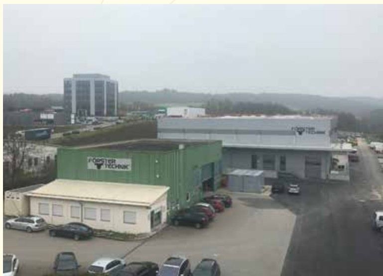
フォスター社の製造工場外観。来年より奥の建物へ製造ラインを移動し、作業の効率化を図る。
