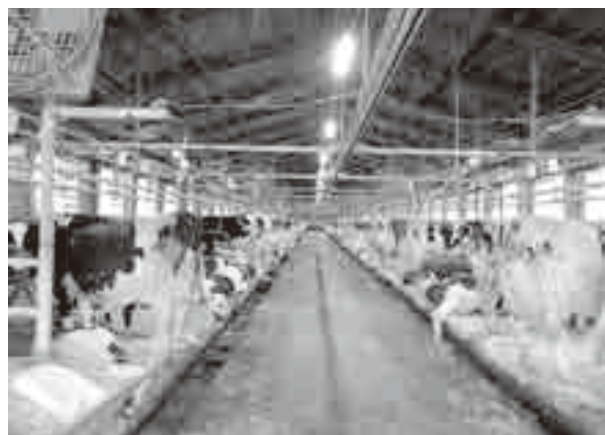
▲ 搾乳牛舎 トンネル換気により夏場でも風が抜ける
