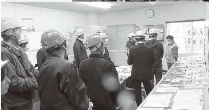
▲ 港湾オペレーター室での作業内容説明
