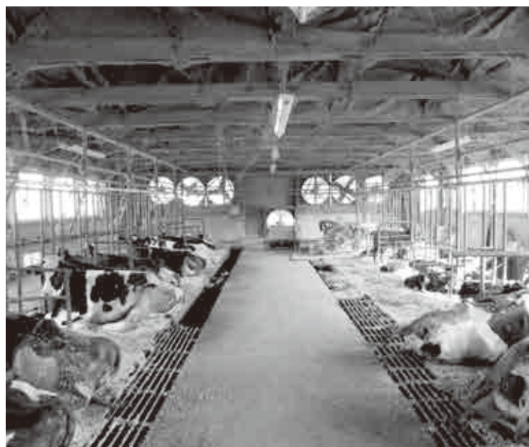
▲ 搾乳牛舎内部とトンネル換気のファン
