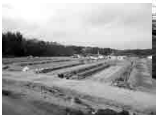
▲ 知多農場 隣の敷地には育成牛舎を建設中
