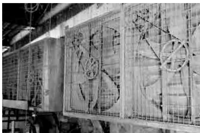
▲ 大型ファンでトンネル換気
