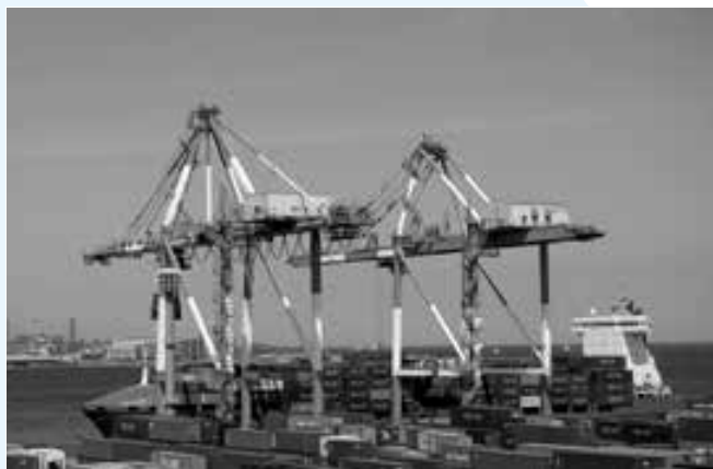
▲ ガントリークレーン
