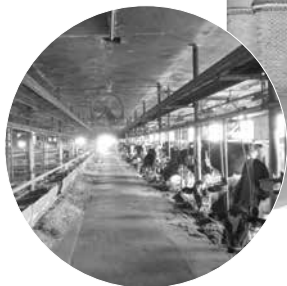
▼ 旧つなぎ牛舎内部
