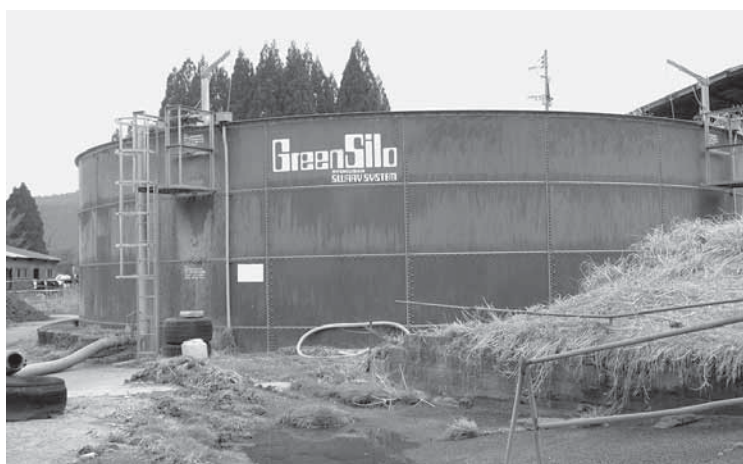
スラリータンク
