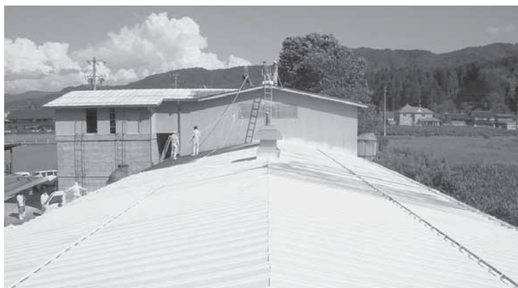
牛舎屋根への石灰塗布作業
