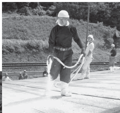
石灰の 塗布作業 ▶
