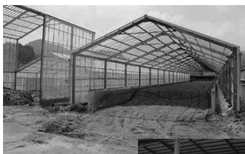
◀ 堆肥発酵乾燥施設
